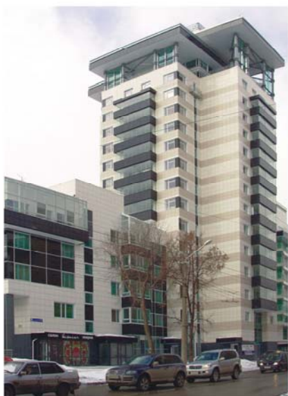
ЖК «Турчаниновский квартал», застройщик – ОАО "ПЗСП"
